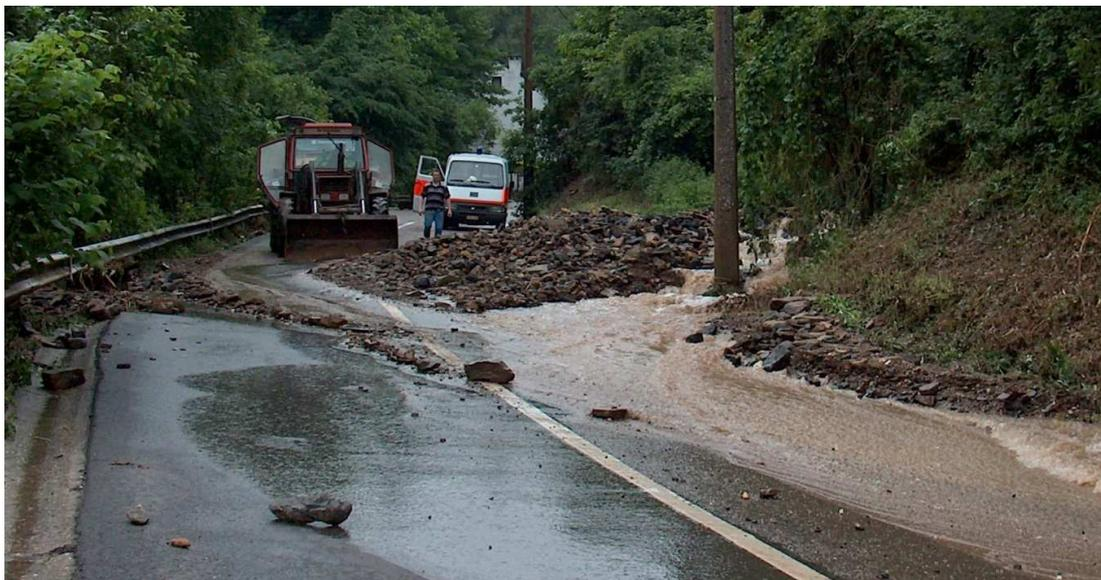
**Figure 5-33 : Dépôt de blocs au niveau du pertuis obstrué durant l'événement d'un affluent du ruisseau du Fond du Moulin (source : riverain)**
